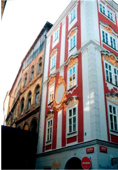
Abb. 7: Nebeneinander von sanierten und nichtsanieren Gebäuden in der Prager Altstadt
